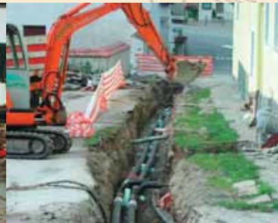
Die Verlegung der Netzleitung
