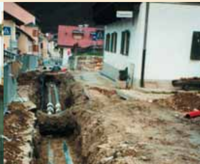
Die Verlegung der Netzleitung
